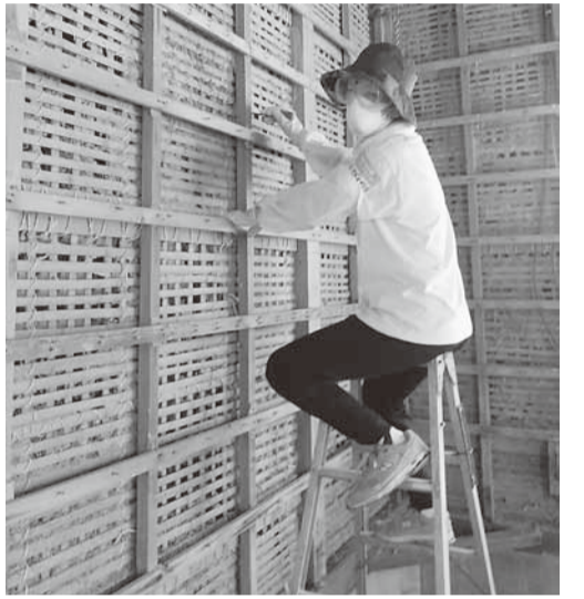
土壁の泥のかき出し
